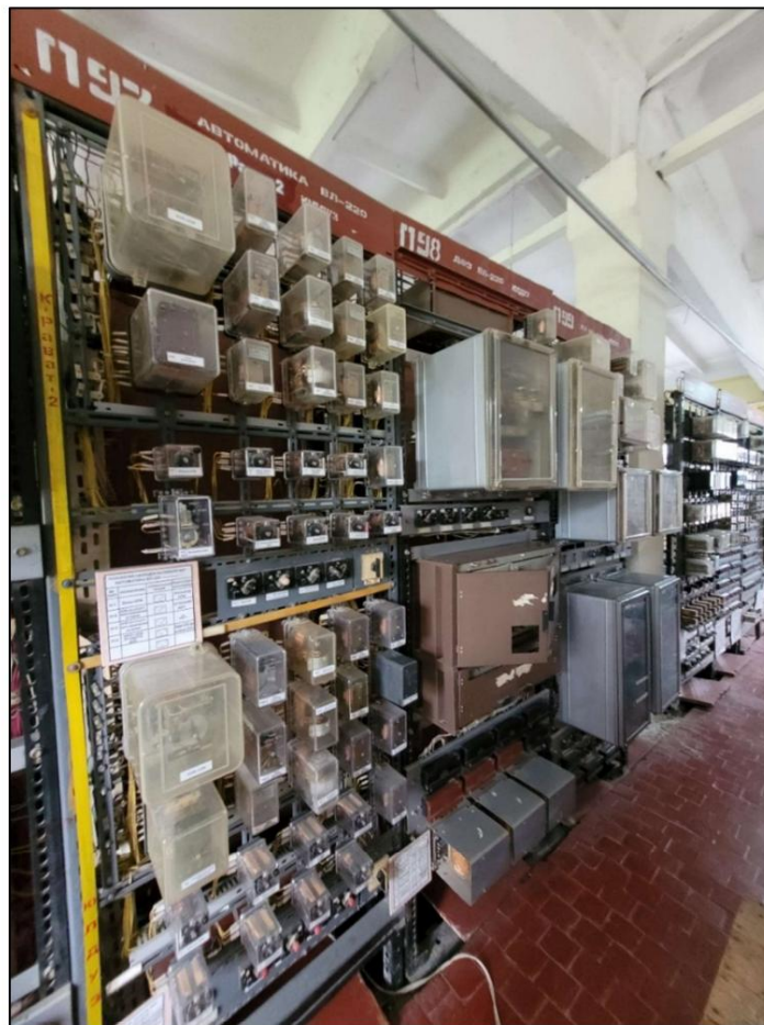
Рисунок 22: Оборудование системы токовой защиты линии 220 кВ Юлдуз на ПС Кристалл
