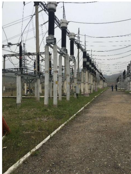
Рисунок 7: Растительность под распределительным устройством, неровная поверхность земли на всей территории распределительного устройства.
