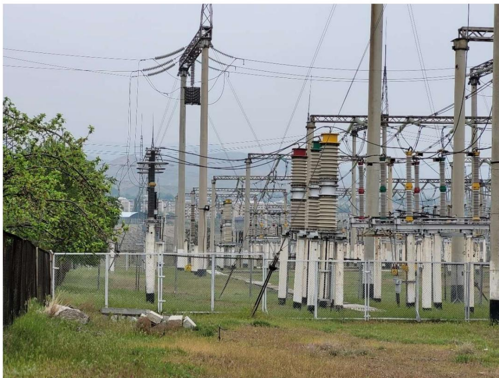
Рисунок 6: Растительность под распределительным устройством и несоосность полюсов.
