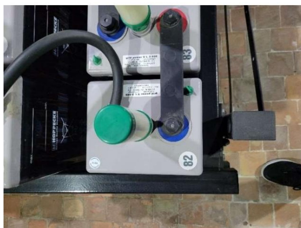
Рисунок 18: Аккумуляторные батареи Krystal SS, модель VL 2-550 с жидким электролитом (свинцово-кислотный, разбавленная серная кислота).
