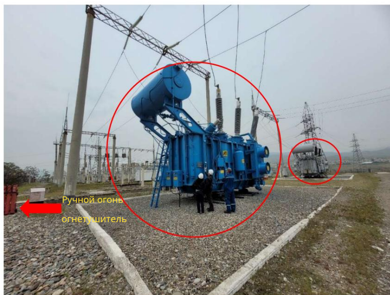
Рисунок 9: Автотрансформаторы подстанции «Кристалл» .
