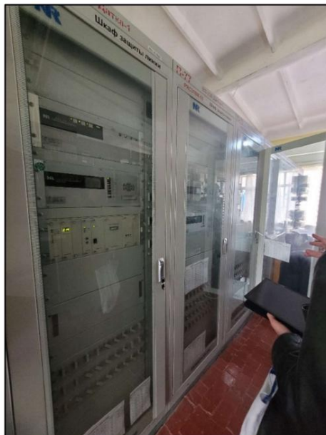
Рисунок 23: Цифровые релейные шкафы защиты линий «Датка» на ПС «Кристалл»
