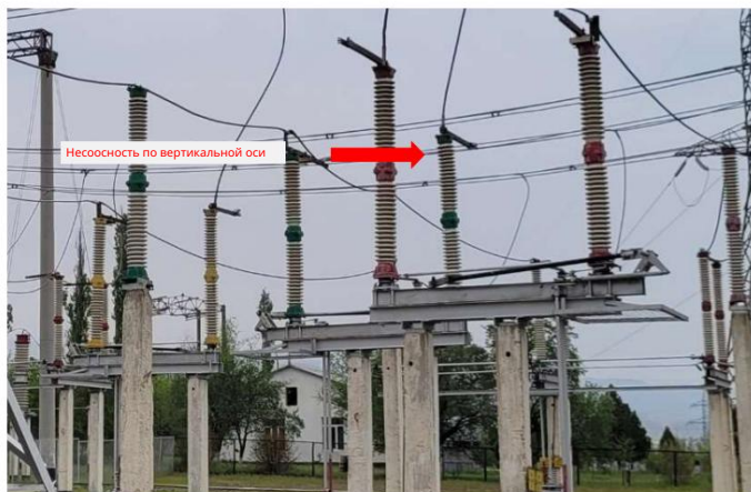
Рисунок 15: Разъединители в СС «Кристалл» в плохом состоянии.
