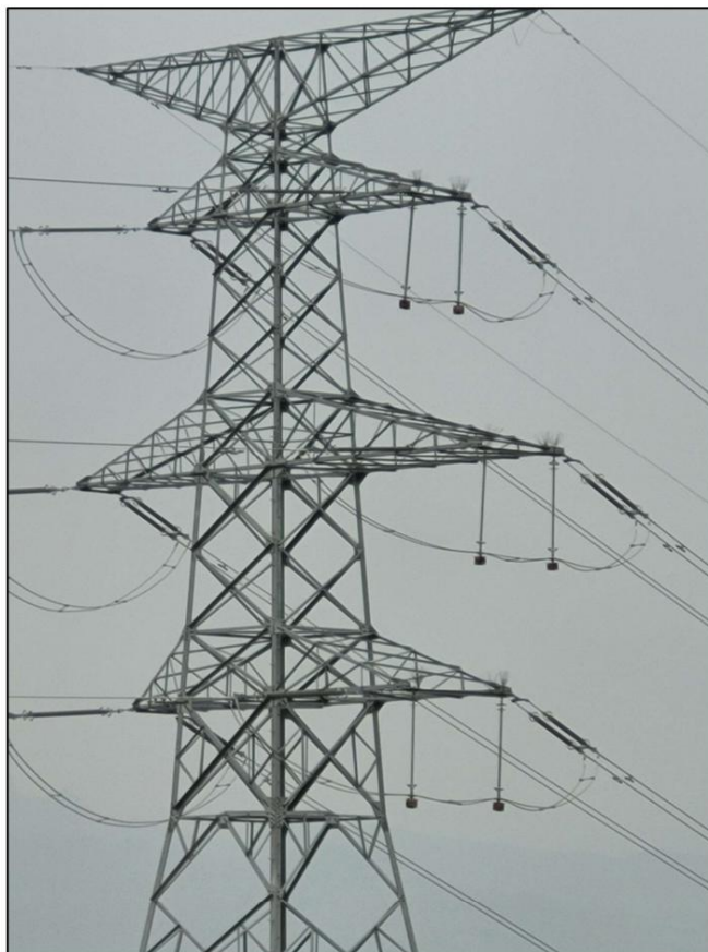
Рисунок 41: Пример применения защиты от птиц на вышке напряжением 110 кВ в Финляндии 7 .
