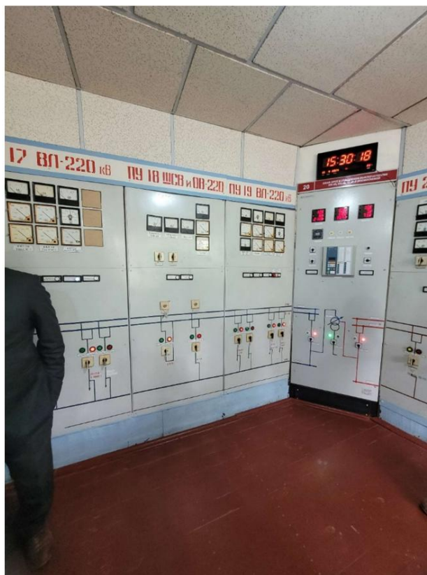
Рисунок 20: Панель управления аналогового типа старой версии Кристалла.
