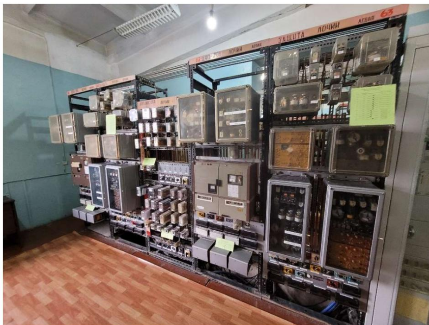
Рисунок 47: Линия Лочина (слева направо) дифференциальная и дистанционная защита.
