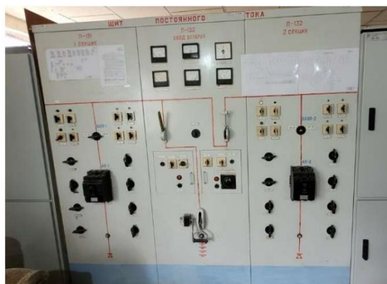
Рисунок 19: Система зарядного устройства аккумулятора с резервным оборудованием.
