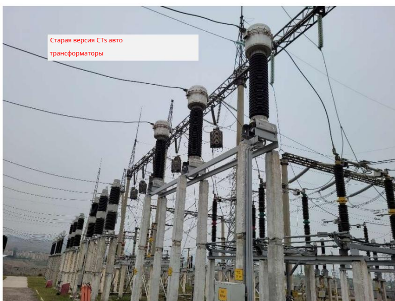
Рисунок 12: Старые трансформаторы тока автотрансформатора.
