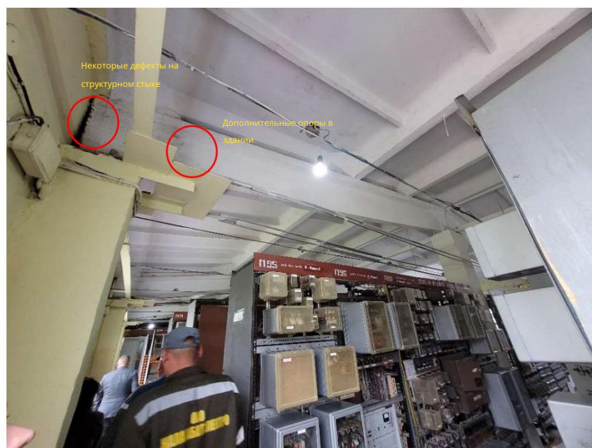
Рисунок 4: Часть здания управления и защиты с некоторыми дефектами.
