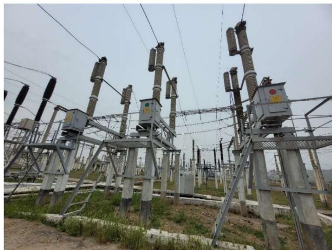
Рисунок 14: Старый выключатель на фидере автотрансформатора, маслонаполненный, имеются утечки масла.
