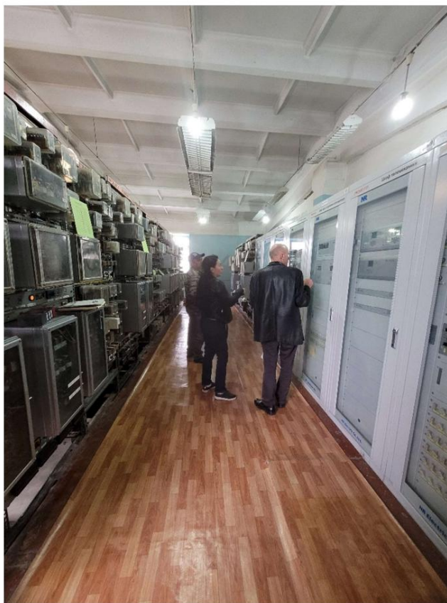
Рисунок 46: Электромеханические и цифровые (Датка 1-2) реле на подстанции Лочин.
