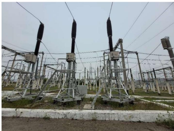
Рисунок 13: Автоматические выключатели в «Кристале» в хорошем состоянии и относительно новые.
