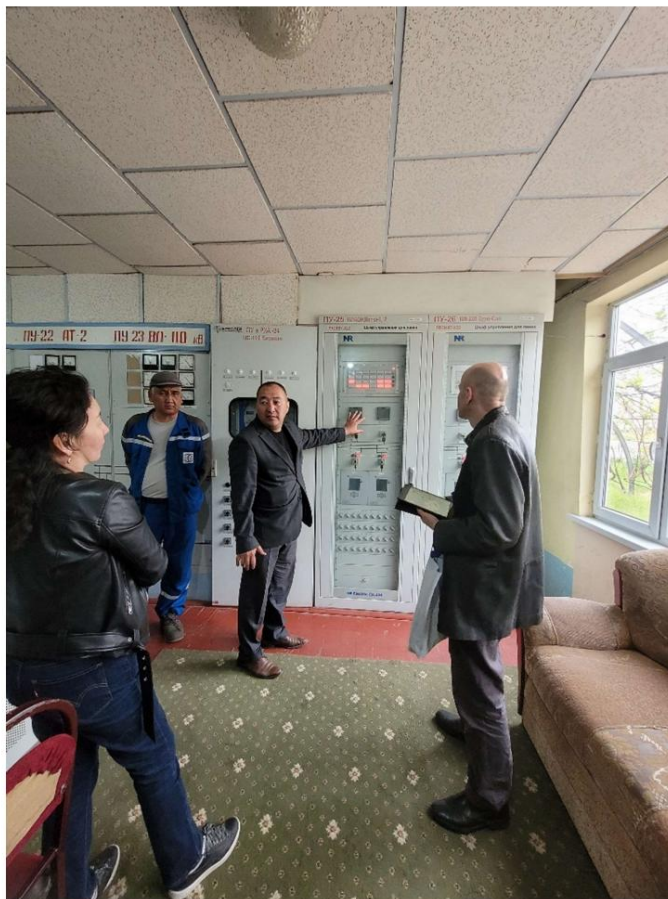
Рисунок 21: щиты управления цифрового типа линии «Датка 1-2» и линии «Крупсай» на «Кристалле».
